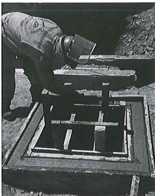
CONCRETO PARA BUZONES ELECTRICOS
