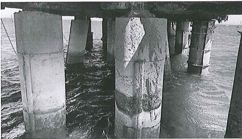
CONCRETO PARA PILOTES
