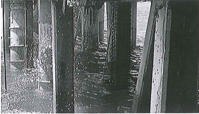
ENCAMISADO Y ENCOFRADO PARA PILOTES
