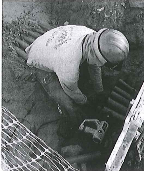
COLOCADO DE CONECTORES A DUCTERIA ELECTRICA LA LLEGADAS A BUZONES
