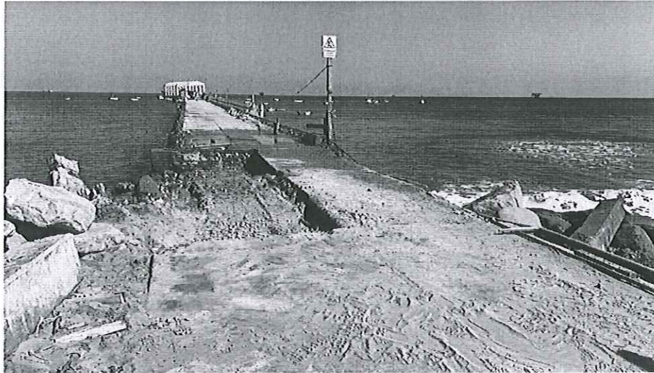
DEMOLICION DE LOSA DE ENTRADA
