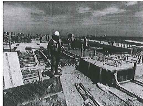
COLOCADO DE CONECTORES A DUCTERIA ELECTRICA LA LLEGADAS A BUZONES
