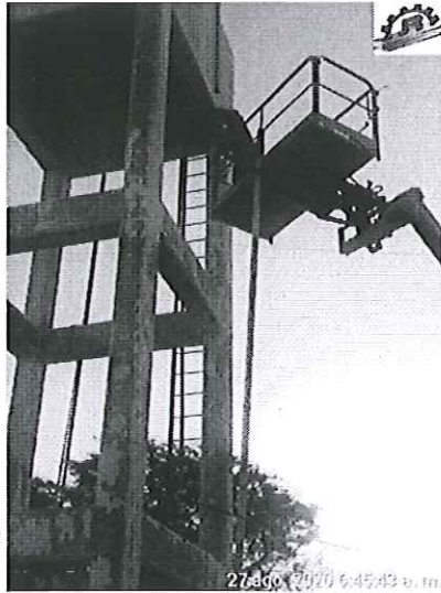
MEJORAMIENTO DE TANQUE ELEVADO
