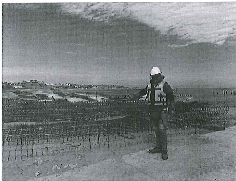
VERIFICACIÓN DE ACERO HABILITADO PARA EL ENCAMISADO DE PILOTES
