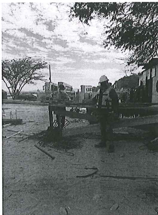
VERIFICACIÓN DE HABILITACION DE ACERO
